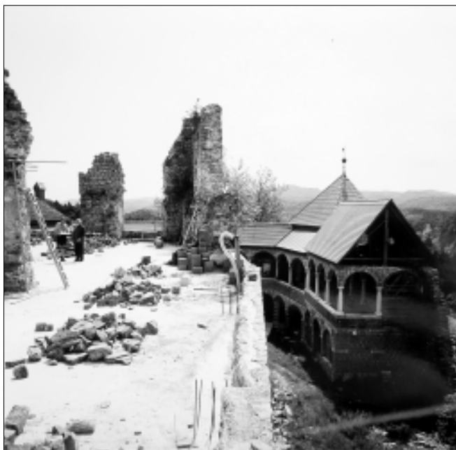
Levo: Zadnji grajski posnetek v letu 2002, gradbišče prvega nadstropja palacij
