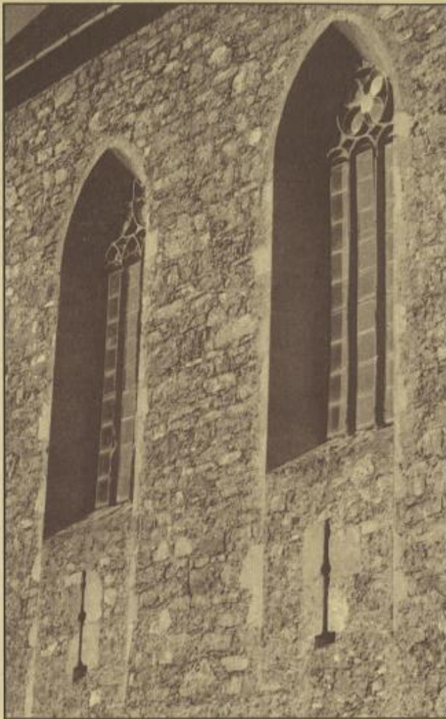
zazidana visoka gotška okna in vstavljene posebno izoblikovane strelnice
