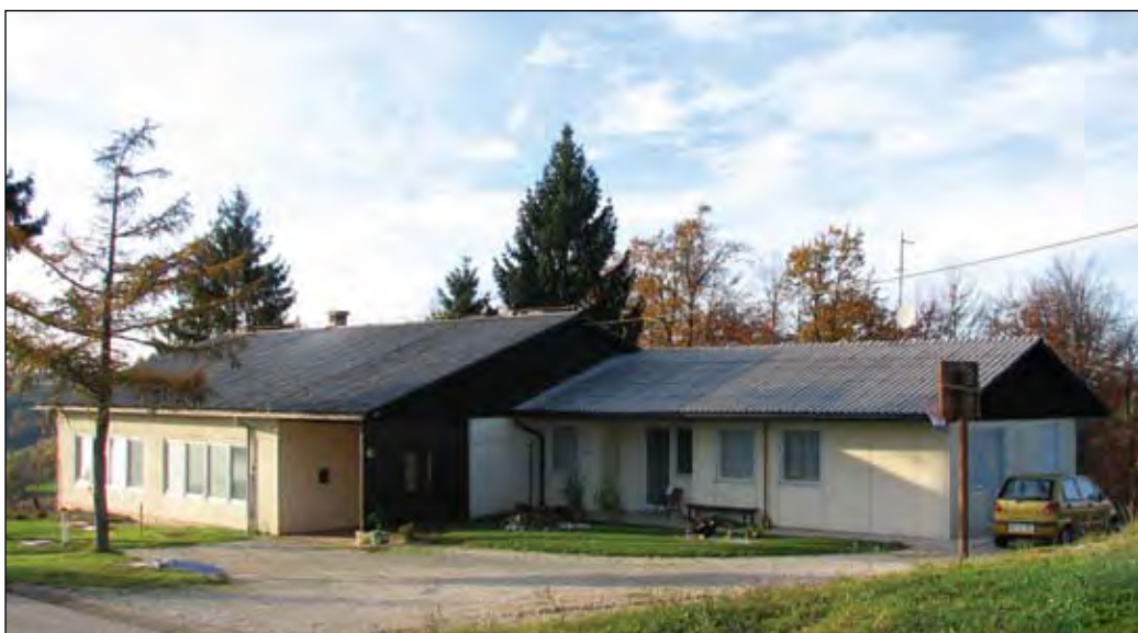
Podružnična šola Jelševce, zgrajena leta 1971. Fotografijo hrani arhiv OŠ Mokronog.
