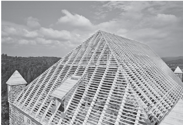
Dokončana nova strešna konstrukcija palacija pred začetkom prekrivanja julija 2005 (foto: Marko Kapus).
