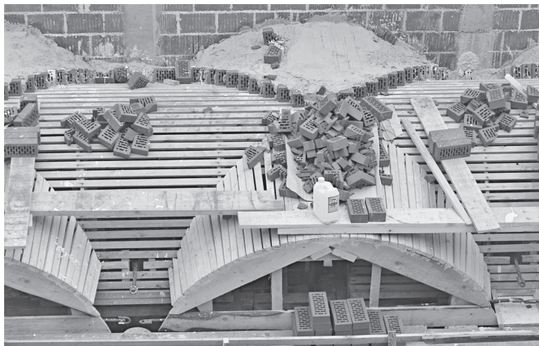
Skrbna ponovna gradnja opečnih križnih obokov južnega arkadnega hodnika septembra 2006 (foto: Igor Sapač).
