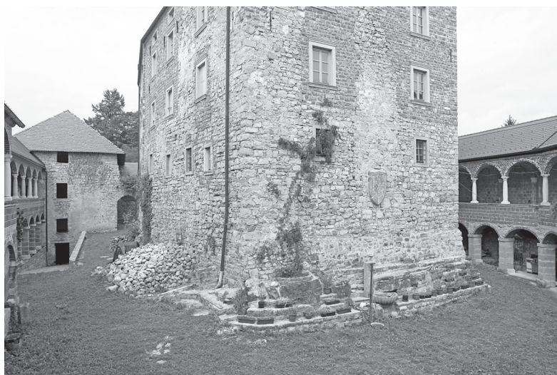
V letu 2011 obzidani skalni podstavek vzhodne stene palacija (foto: Marko Kapus).
