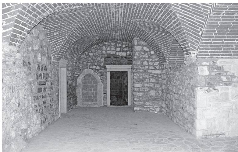
Nov tlak in zaščiteno zidovje v veži obnovljenega palacija leta 2010 (foto: Igor Sapač).
