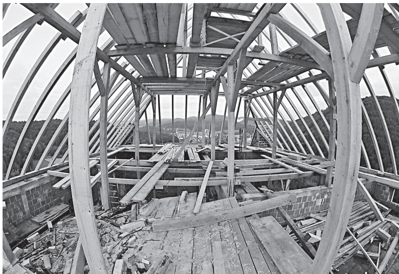
Postavljanje nove strešne konstrukcije vrh obnovljenega palacija junija 2005 (foto: Marko Kapus).
