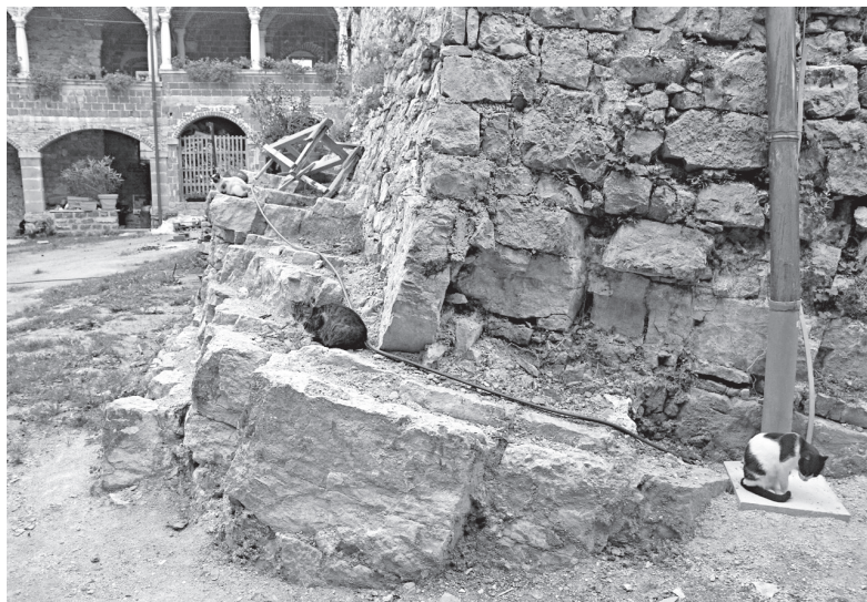
Očiščeni naravni skalni podstavek vzhodne stene palacija septembra 2006 (foto: Igor Sapač).
