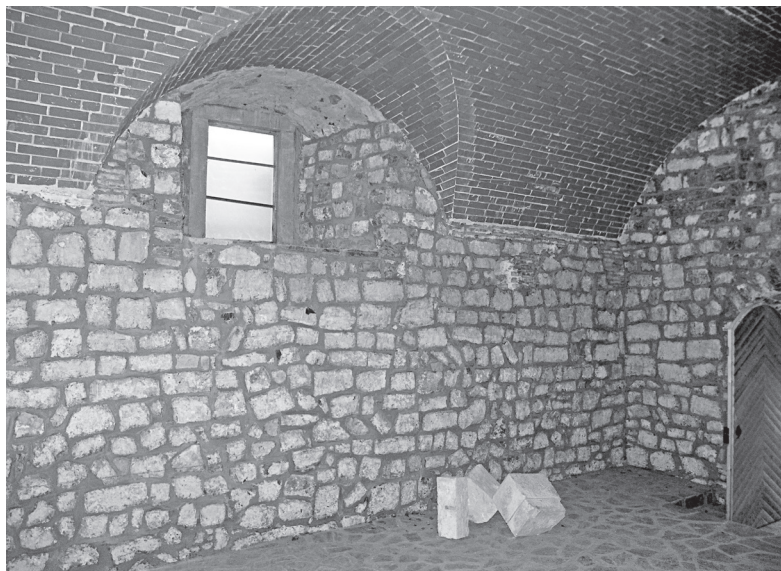
Nov tlak in zaščiteno originalno zidovje v pritličju nekdanje romanske visoke utrjene hiše leta 2010 (foto: Igor Sapač).
