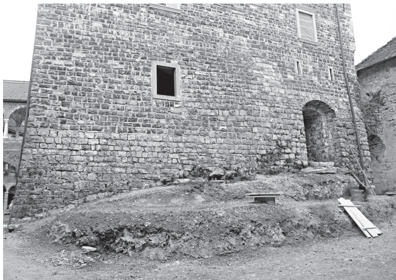
Očiščevalna dela pred zahodnim vhodom v palacij septembra 2006 (foto: Igor Sapač).
